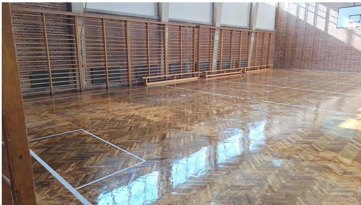
Za vreme i nakon završenih radova
